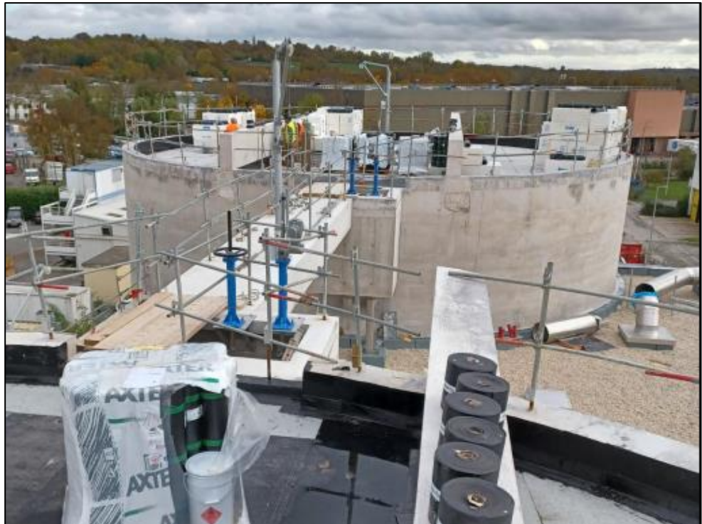
Avancement au 1 er septembre 2023
