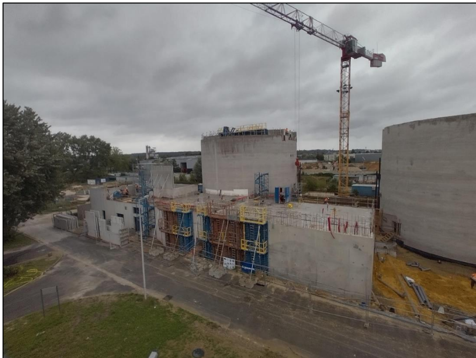
Avancement au 1 er septembre 2023
