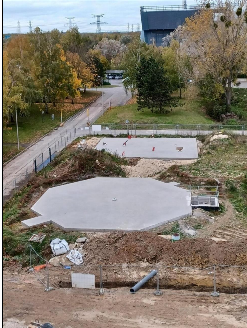
Dalles du gazomètre et de l'unité d'épuration
